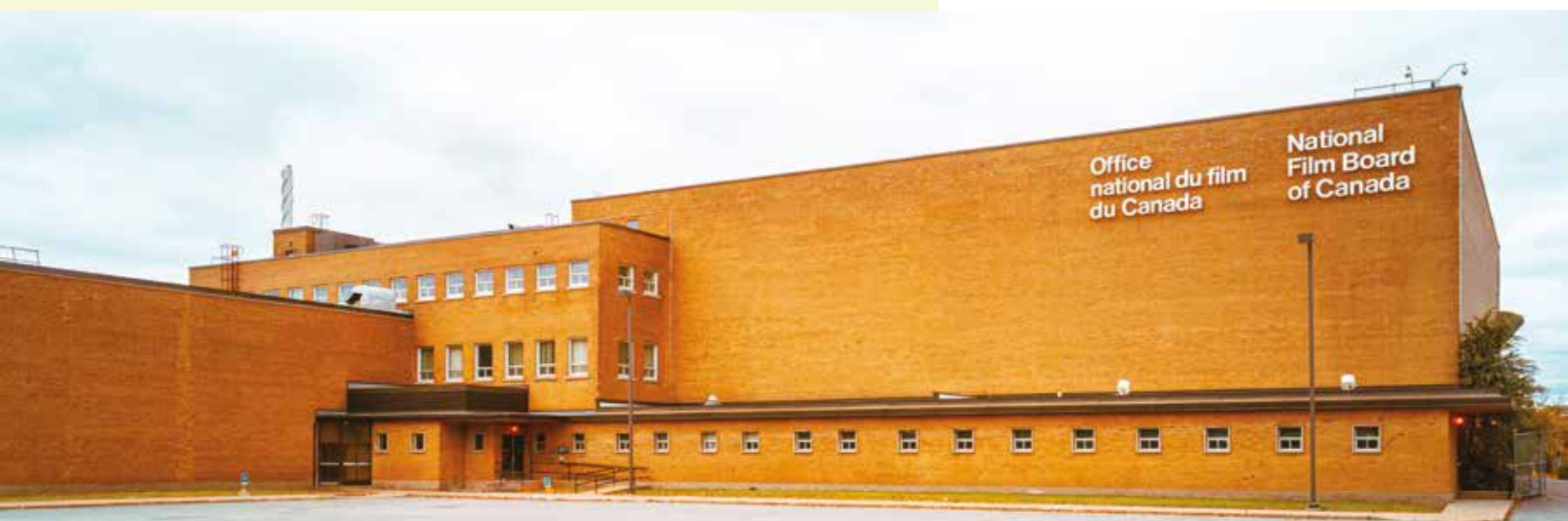
Ancien bâtiment de l'Office national du film du Canada (ONF), arrondissement de Saint-Laurent
